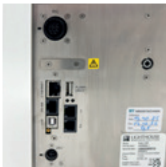
OPZ-Anschl sse vor Umbau
